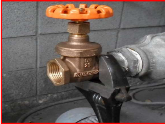
- Válvula Rosqueada, Utilizando Chave Inglesa
